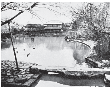
現在の保健室付近から南方面を望んでいる。右手には梅林が広がっていた
